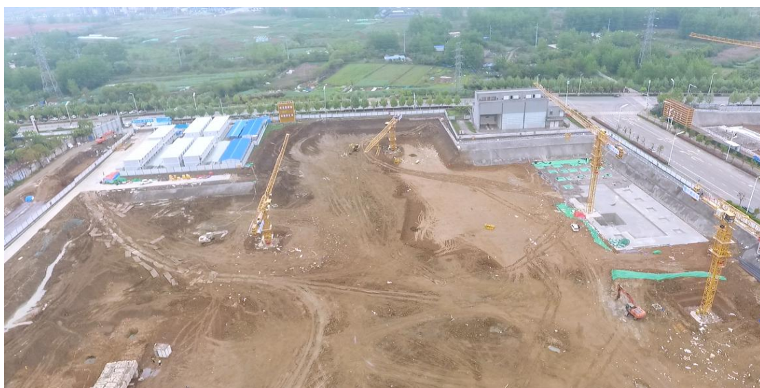
图 1.1-2 项目现场情况
