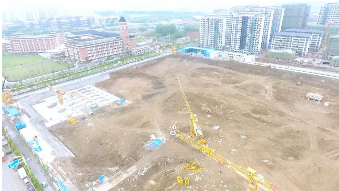
图 1.1-1 项目现场情况
