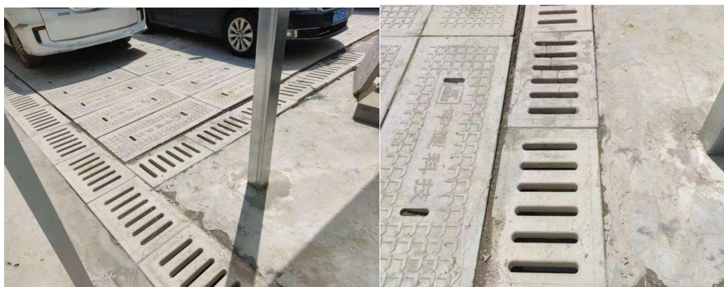
施工生产生活区临时排水沟
